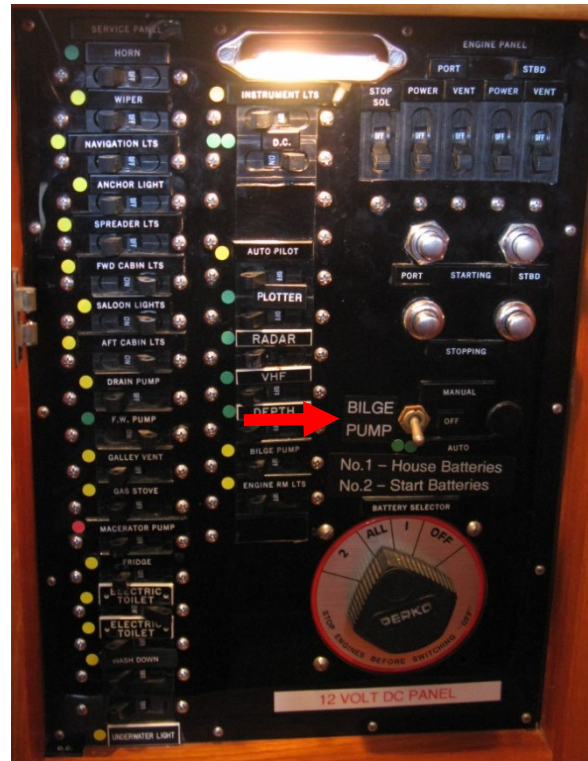
12 VOLT DC POWER PANEL
