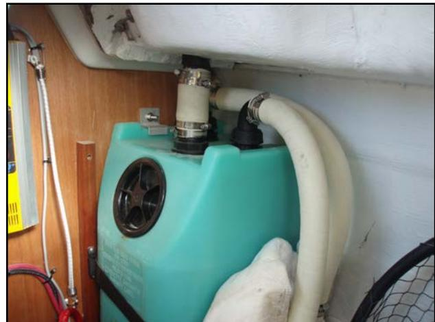
DO NOT CONFUSE THE HOLDING TANK CAP AND THE DIESEL FUEL TANK FILLER CAP. BOTH ARE LABELLED. READ BEFORE USING EVERY TIME.
